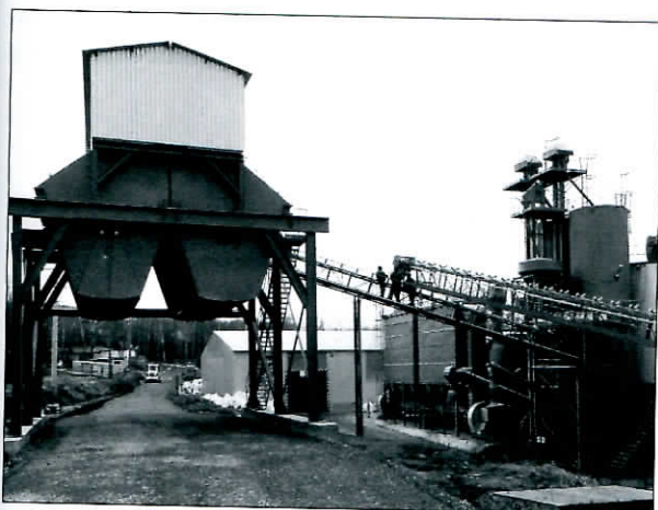
Abb. 2: Neue Anlage zur Verladung von erdfeuchtem Schiefermehl in Jarnoltowek/Polen.
