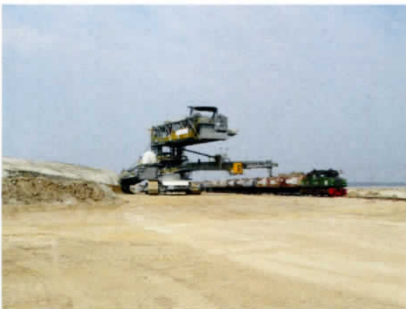
Bild 1 Ressourcenschonung: Rückbau Tonhalde Big Brandenburg
