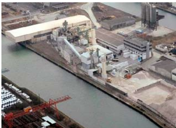
»11 Perlite plant in Dortmund (Photo: Knauf Perlite) »11 Perlitwerk Dortmund (Foto: Knauf Perlite)
