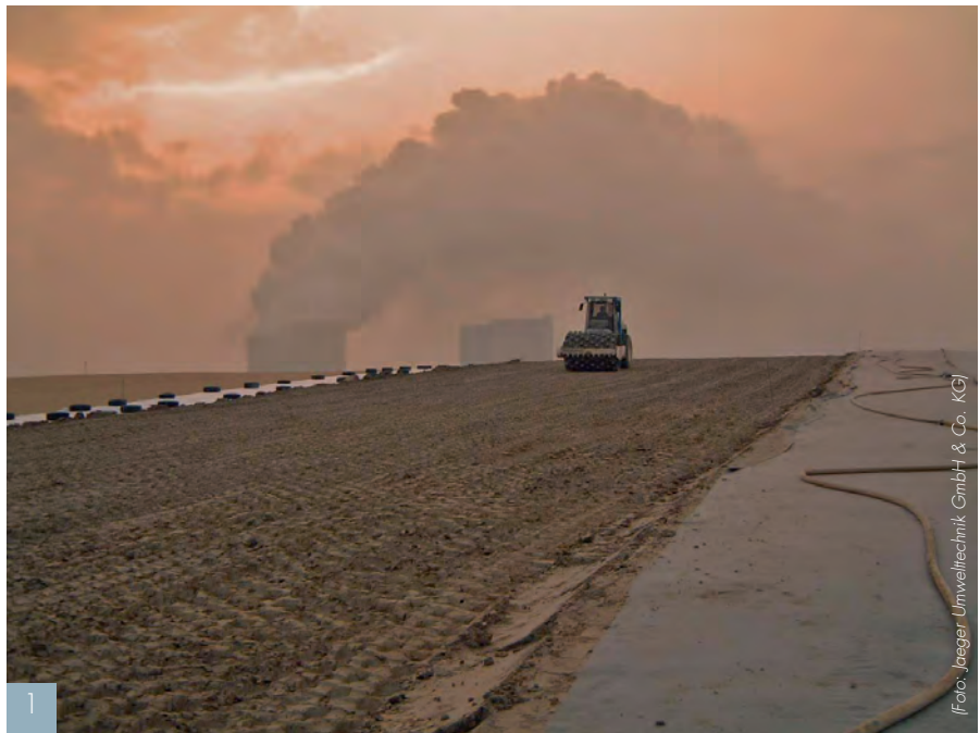
Einbau von 170.000 t Dichtungsmaterial auf der Deponie Terpe/Deutschland
