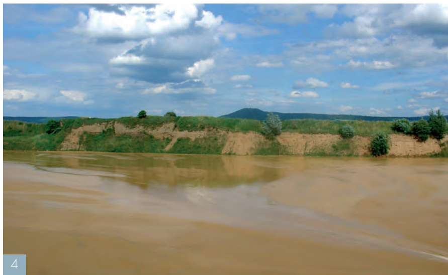
Typischer Schlammteich mit rund 1 Mio. t feinsten Minerale
